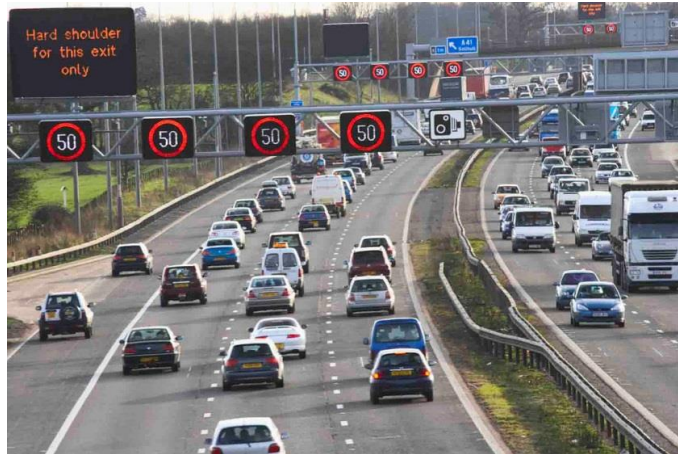
Figura 5-151. Ejemplo de pórtico de PMV y hombro izquierdo habilitado para transitar
