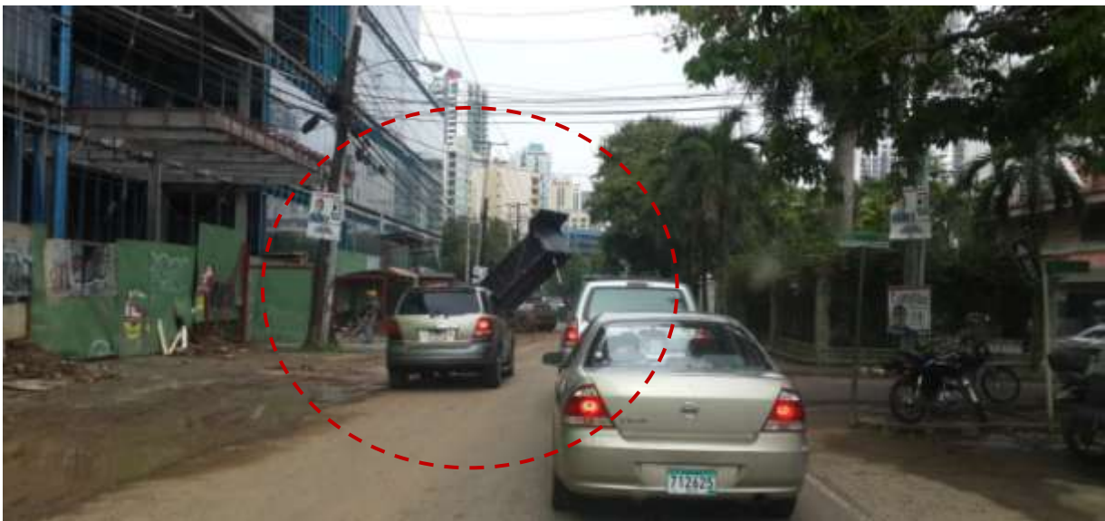
Figura 3-165 Obstrucción de la circulación vehicular en ciudad de Panamá por descarga de material de construcción
