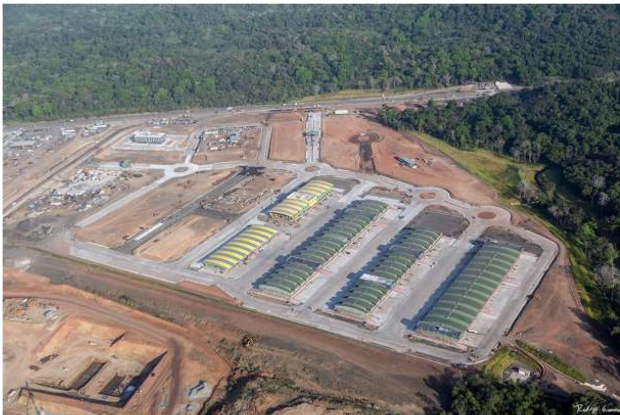
Figura 3-33 Obras del Mercado Central de Abastos
