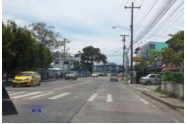
Demarcaciones en condiciones regulares
