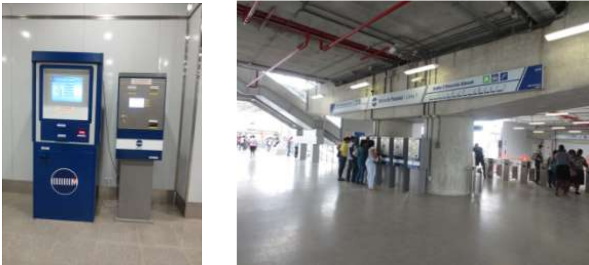
Figura 3-151 Dispositivos de recaudo en estaciones Metro
