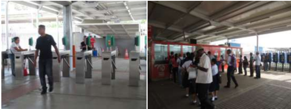
Figura 3-150 Dispositivos de recaudo zona paga Maraón
