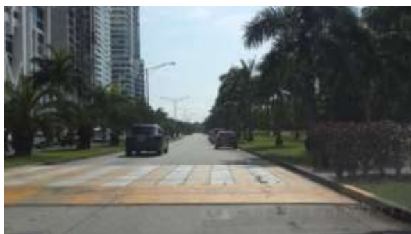
Resalto elevado para cruce peatonal en Ave. Paseo del Mar (Costa del Este)
