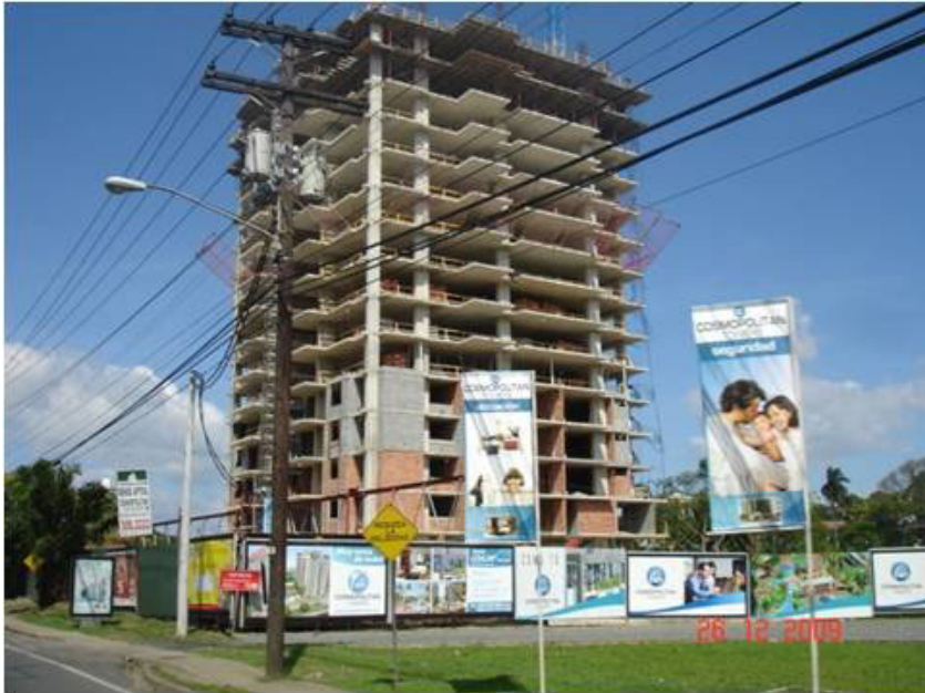
Edificio en Construcción
