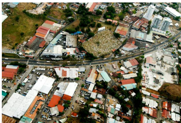
Vista General del Sector E sobre el Cementerio de Pueblo Nuevo
