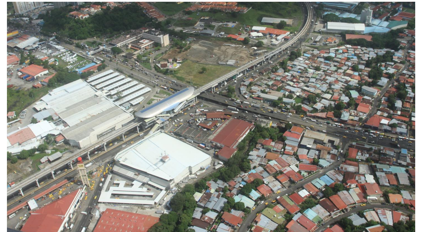
Figura 43: San Miguelito, vista desde el sur de la estación existente Línea 1 de Metro
