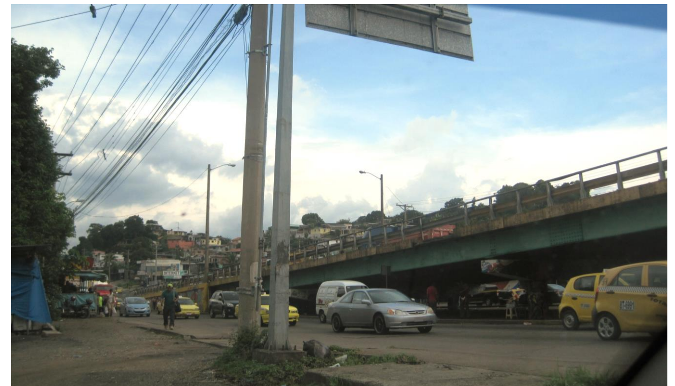
Figura 25: Falta de espacio destinado a los recorridos peatonales
