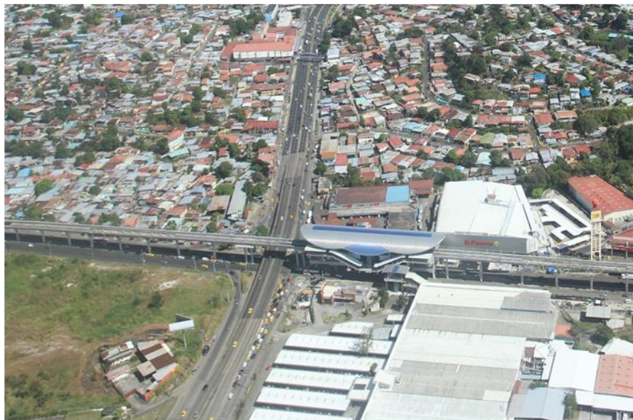
Vista desde el oeste de la actual estación de San Miguelito Línea 1, punto de conexión con la futura Línea 2 y su estación
