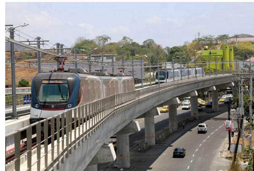
Figura 8: El metro elevado marca el carácter de la vía por la que transcurre
