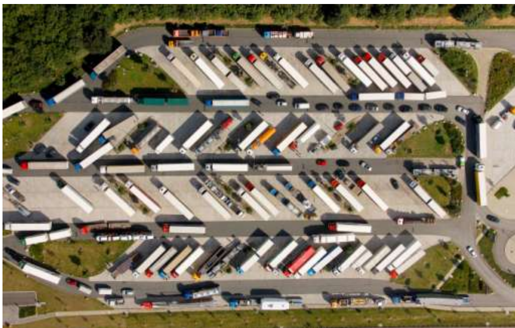
Figura 4-38 Área de estacionamiento para camiones en Alemania
